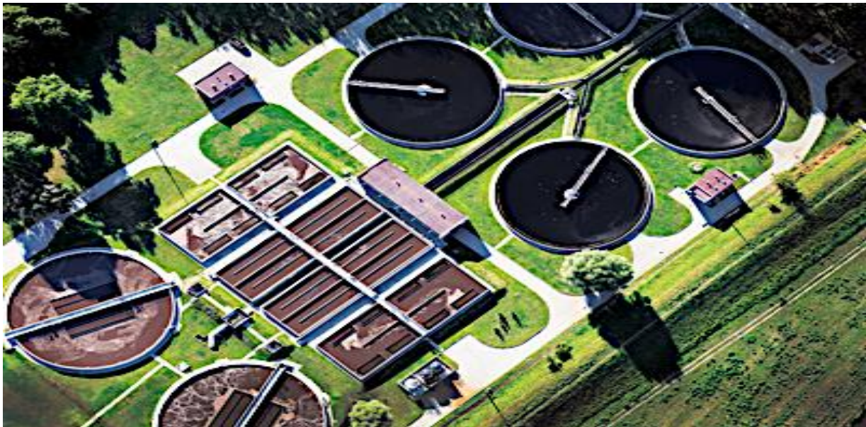
Fig. Tratamento de águas e residuais
