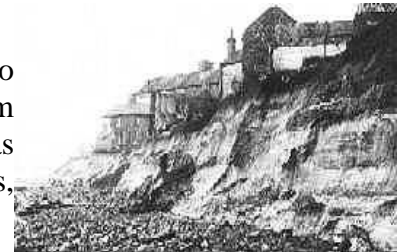
Fig. 5.23. Erosão costeira no Mar do Norte, Reino Unido, mostrando os efeitos desastrosos do rápido recuo das falésias devido à erosão de fortes ondas
