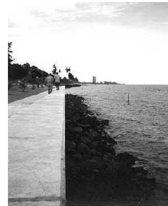
Fig. 5.22. Obras de protecção da costa junto ao Clube Naval, Maputo
