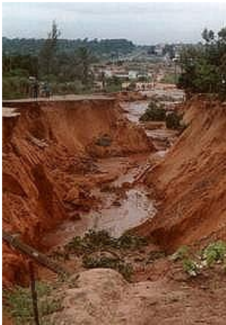
Fig. 5.1. Vala aberta no Bairro do Trevo. Março de 2000
