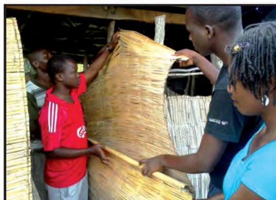
Montagem de paredes na latrina
