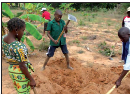
Construção de latrinas. Primeiramente a fundação.
