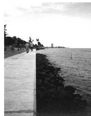
Fig. 5.22. Obras de protecção da costa junto ao Clube Naval, Maputo
