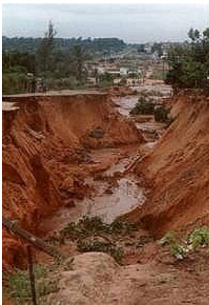
Fig. 5.1. Vala aberta no Bairro do Trevo. Março de 2000
